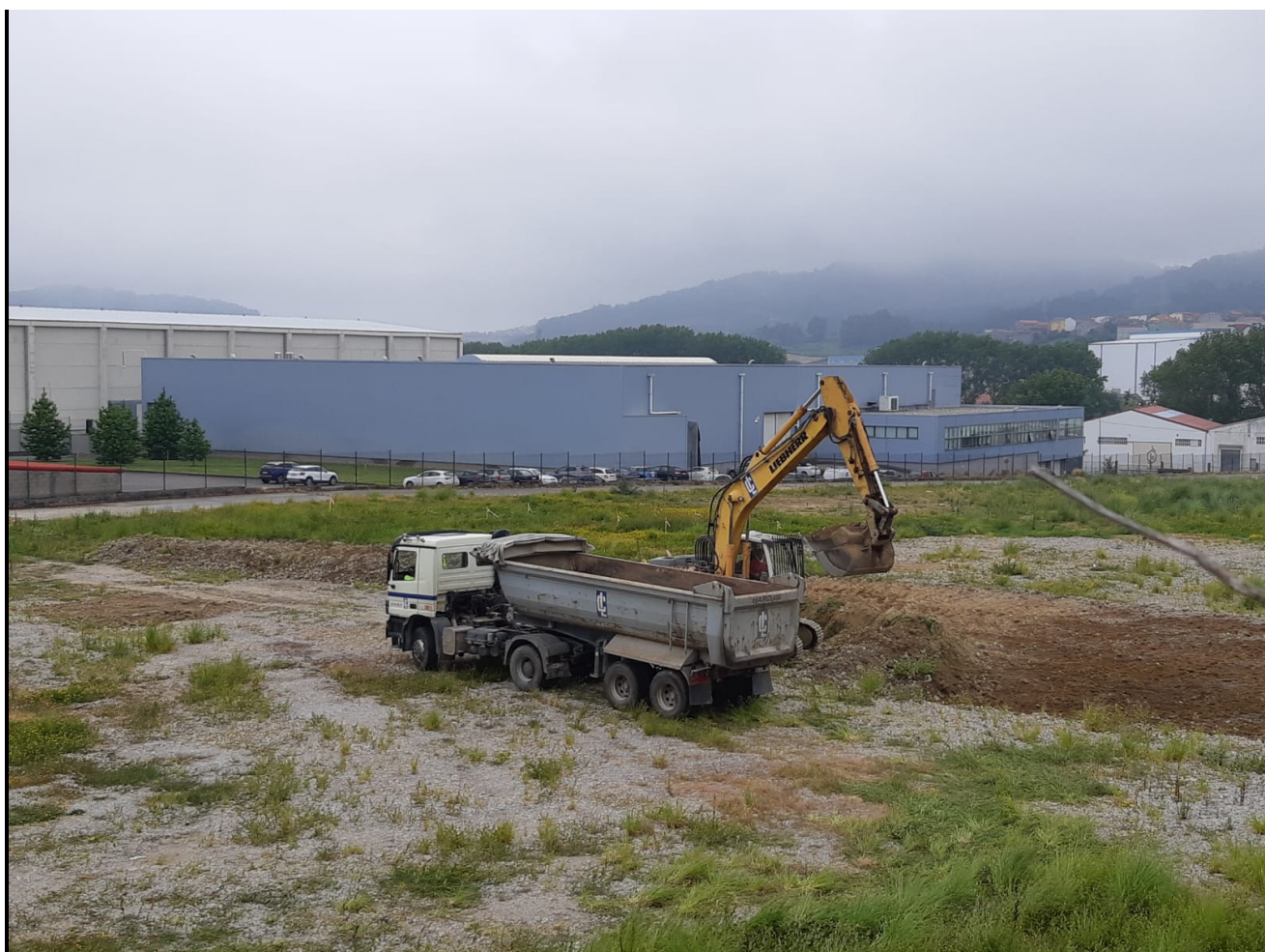
Excavadoras y camiones en las obras que dan inicio al parque Nexus Sabón de Starco Property. Foto: S.P.
