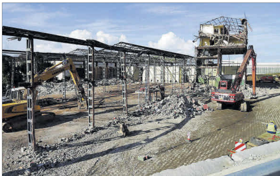
Trabajos de derribo de la nave de Gabesa, ahora propiedad de Inditex, en el polígono de Sabón. // I. A.
