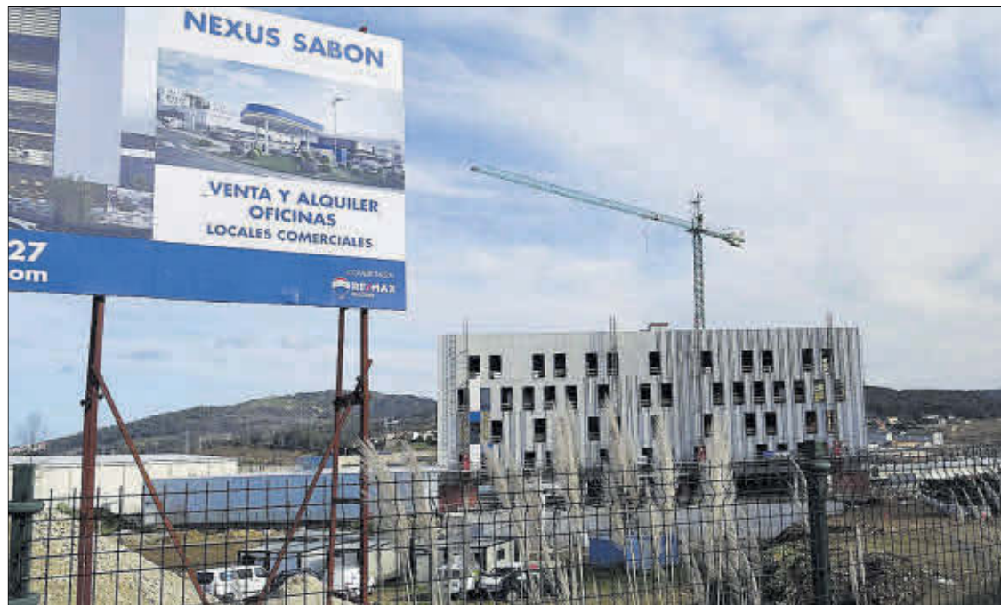
Construcción de un edificio en el solar del proyecto de Nexus Sabón. // La Opinión
