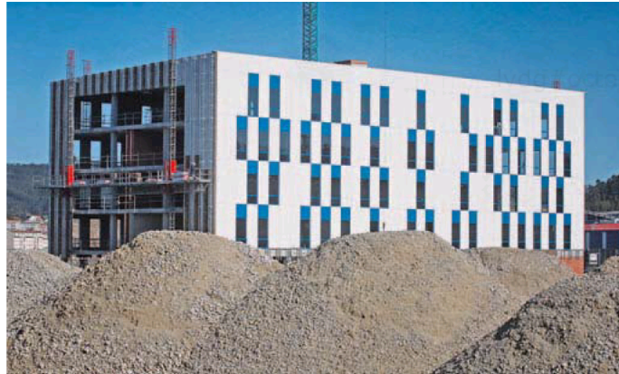
El primero de los tres bloques de oficinas estará concluido en el mes de julio. VÍTOR MEJUTO
