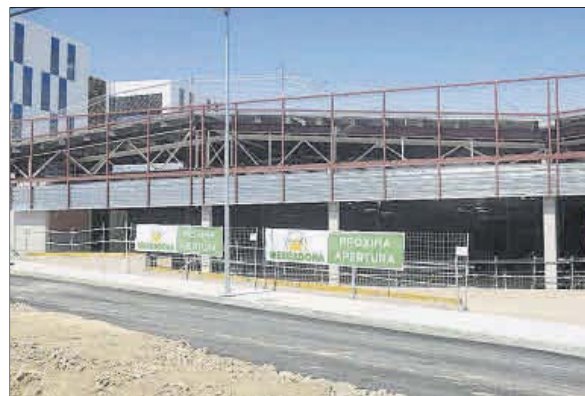
Lateral del primer edificio de oficinas y estructura del futuro Mercadona de Nexus Sabón. // I. A.
