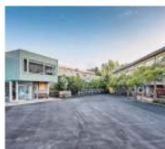
Edificios del colegio Luis Seoane.
